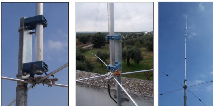
L'antenne avec des radiaux pleins peut être installée à n'importe quelle hauteur. La version avec des radiaux en fil métallique sera plus performante si elle est installée à 10-20 cm au-dessus du sol, avec les radiaux sur le sol ou sur le toit.
